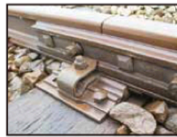
Instalación con tuercas normales
